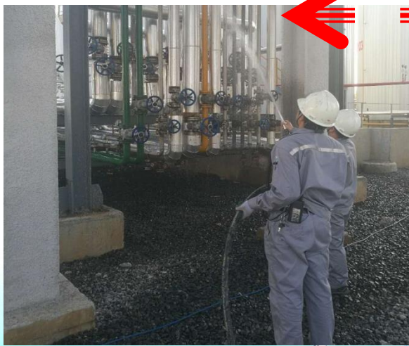
2017. 6 管道打压、吹扫清洗
